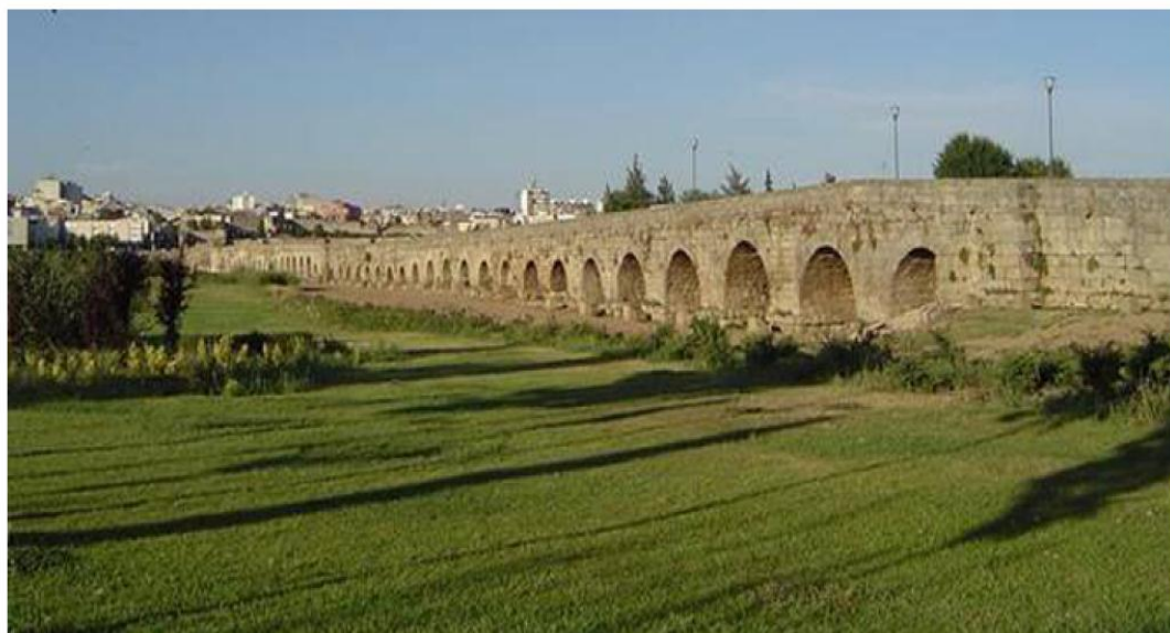
Parque del Puente Romano de Mérida
